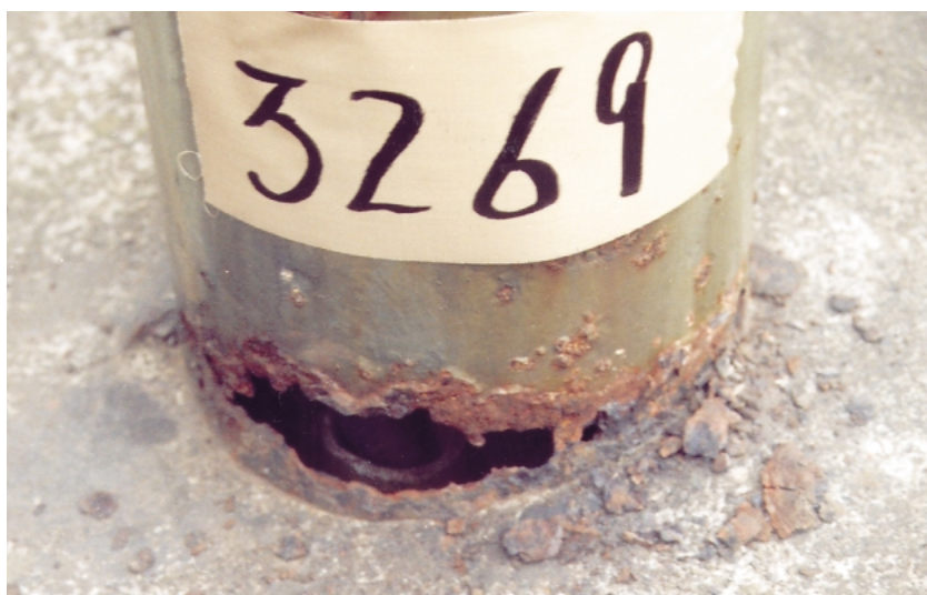
▲ 地際部が錆び、孔が開いた状態
