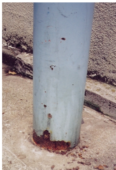
▲ 地際部 犬の尿により錆びた状態
