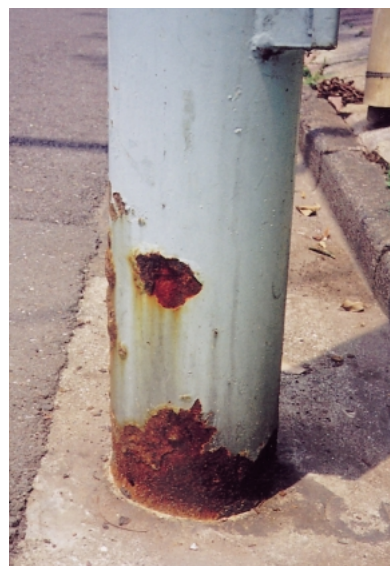
▲ 地際部 犬の尿により錆びた状態
